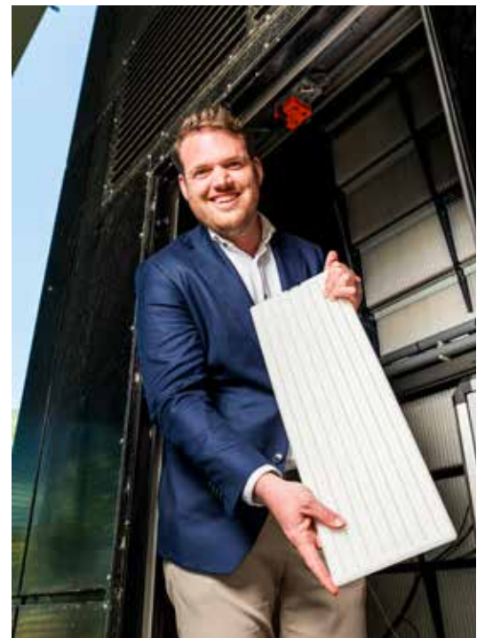
Bert van Dorp toont een koelelement van de PCM-buffer in de klimaattoren.
