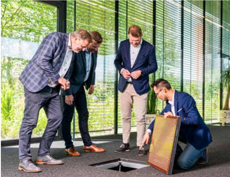
Het gebouw wordt onder andere op temperatuur gehouden met vloerventilatie die zorgt voor efficiënte inblaas van koele lucht van onderaf.
